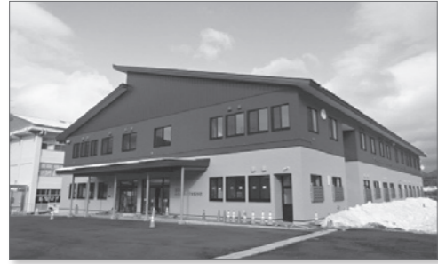
△小・中学部校舎（外観）
