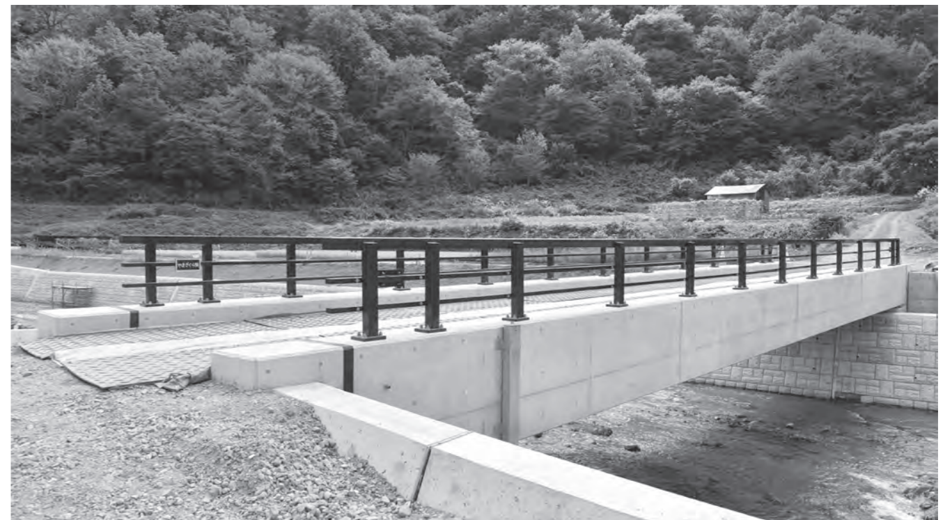
▲架設直後のやまざくら橋
