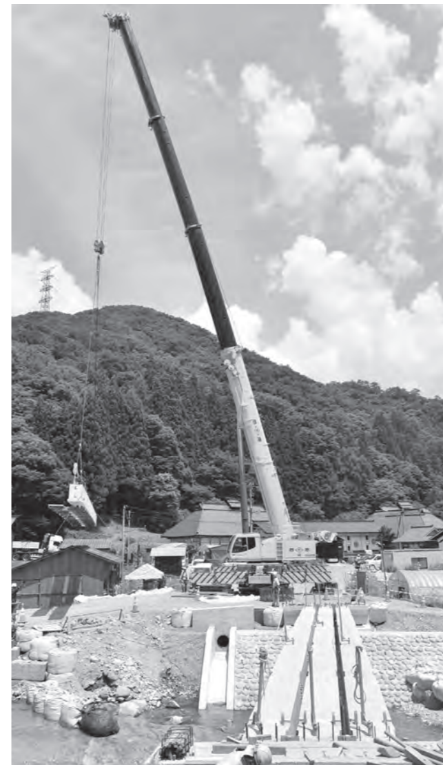
▲200トンのトラッククレーンで橋桁を設置（7月20日）
