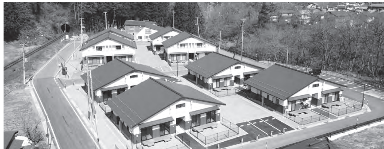
◀建て替えられた姫川団地
