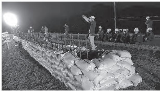
▶積み上げられた土のう
