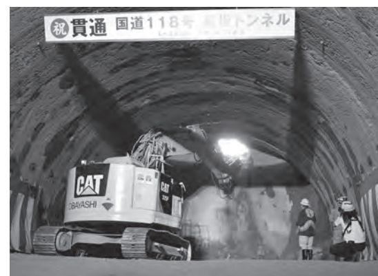
▲掘削機で穴を開け貫通
