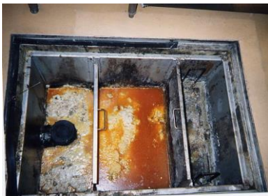
分離汚水マスの清掃前
