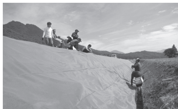
▶抑草シートを敷設する団員ら
