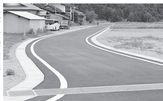
▶新設された姫川南原線
