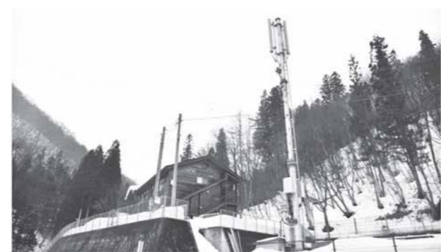
◀完成した通信用鉄塔
