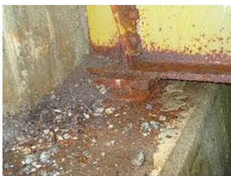
写真-3 支承の腐食
