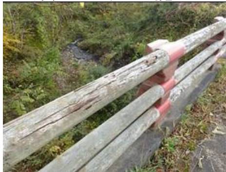
写真-8 防護柵の変形
