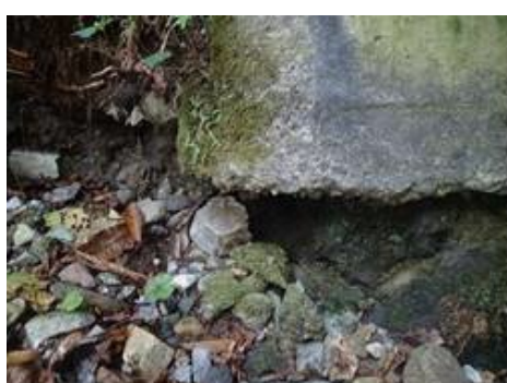
写真-6 下部工の洗掘
