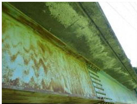
写真-2 鋼桁の塗装劣化
