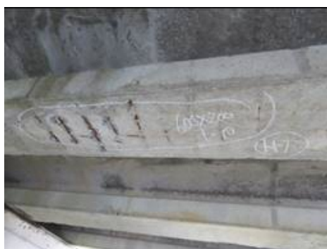
写真-4 RC橋 主桁の鉄筋露出
