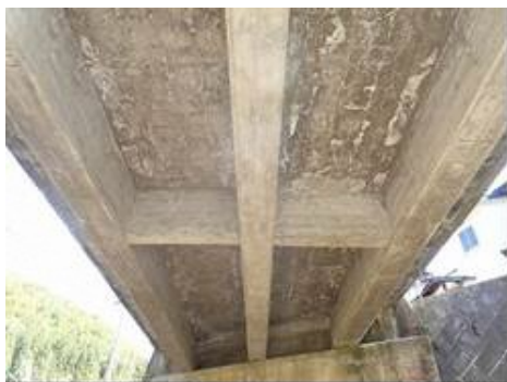
写真-5 RC橋 床版ひびわれ
