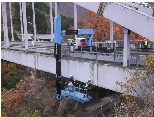
橋梁点検車での点検
