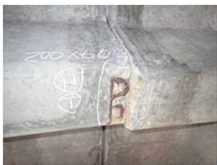
写真-1 主梁の鉄筋露出 (Aタイプ)
