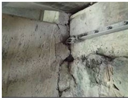
写真-4 山側・受台の剥離 (Cタイプ)
