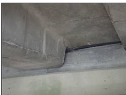
写真-3 主梁のひびわれ (Bタイプ)
