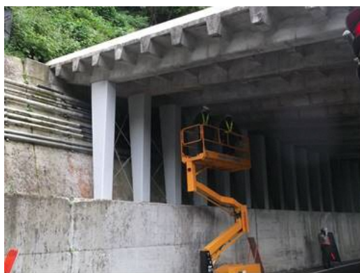
高所作業車での点検
