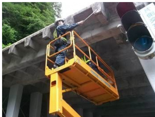
近接目視点検状況
