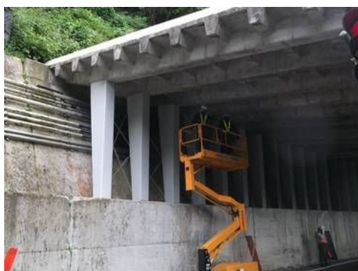
高所作業車での点検
