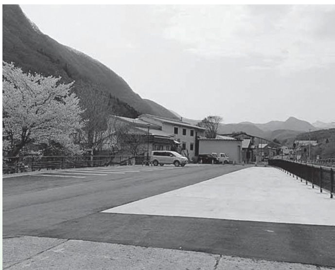
湯野上温泉駅南に新設された駐車場
