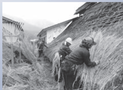
大内宿の葎き替え作業の様子
