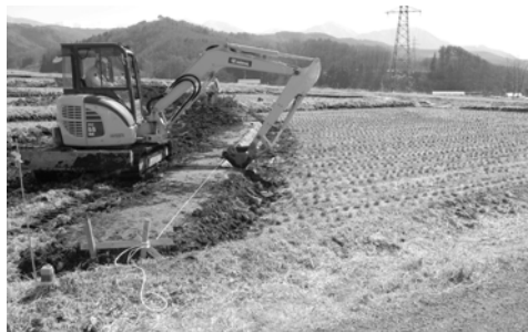
一部着工された張平地区
