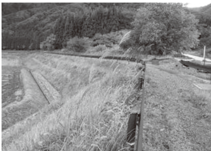
▲ 檜原地区災害復旧後
