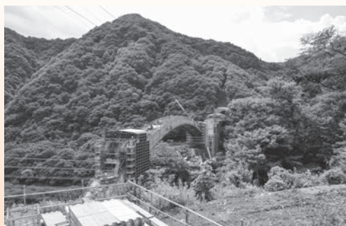
建設中の下郷大橋 (小出地区)
