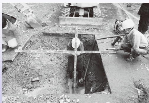
漏水工事のようす
