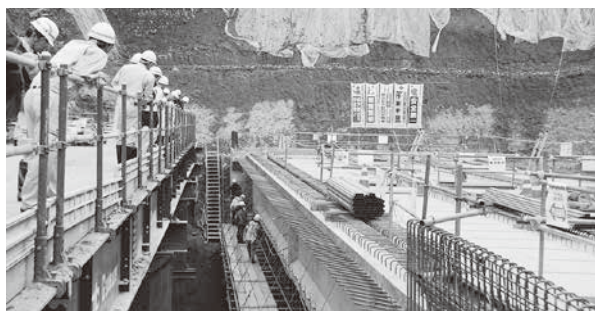
湯野上バイパス3号橋梁下部工を見学
